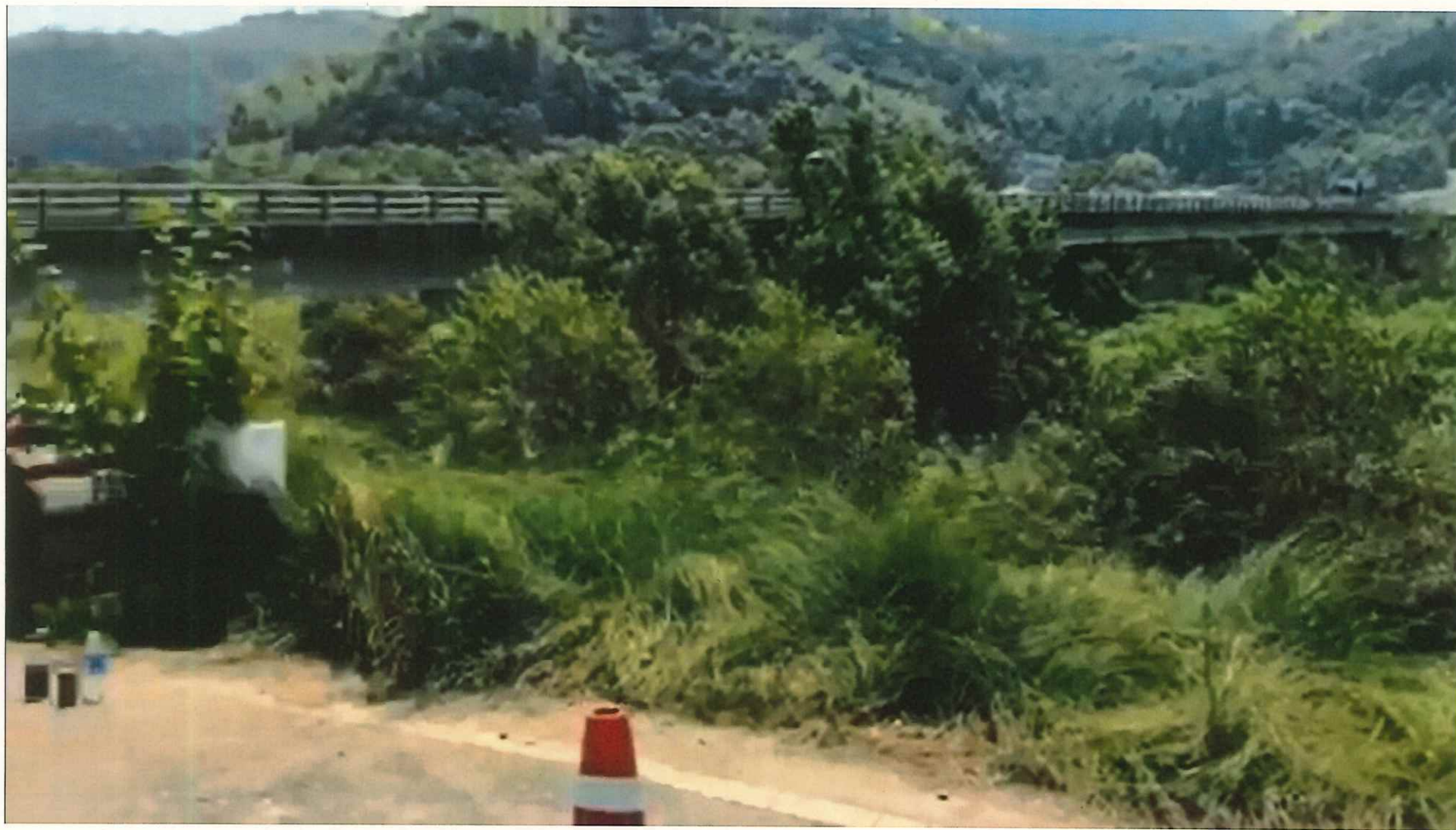
2018年11月21日 参院災害対策特別委員会提出資料 日本共産党 仁比聡平 出典：2018年7月15日小田川左岸破堤地点から小田川を仁比聡平事務所撮影
